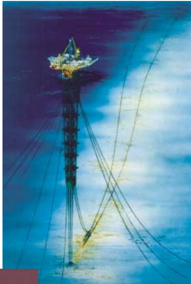
Aker Mäntyluoto on rakentanut öljynporauslauttoja vuodesta 1972. Kuvassa Porissa rakenteilla oleva uudentyyppinen Spar-öljyntuotantolautta.
