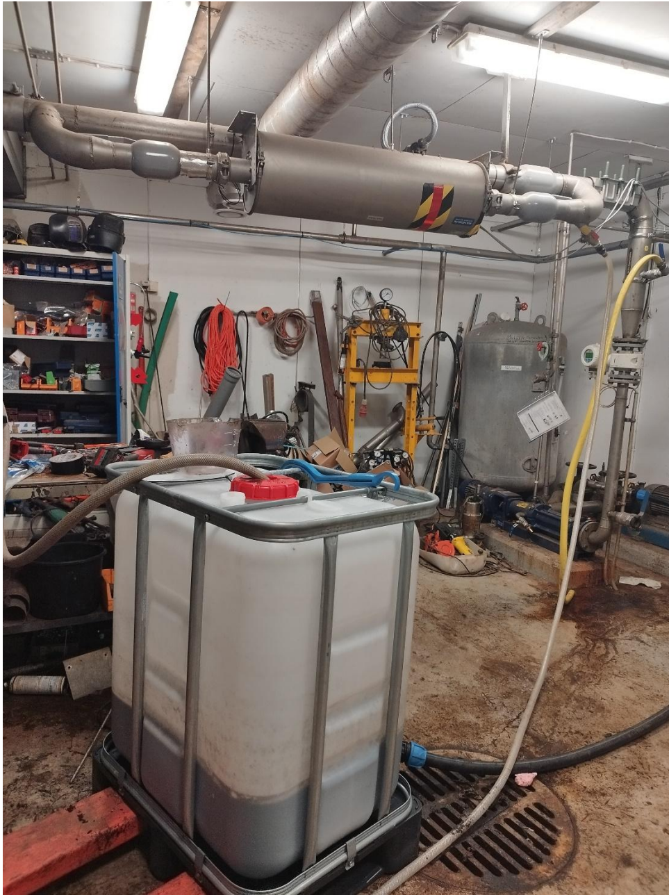
Kuva 10 Ultraäänilaitteisto Virtain jätevedenpuhdistamolla. Edessä alhaalla Huittisten puhdistamolta tuotu palautuslietekomtti ja yläpuolella varoitusteipein merkitty ultraäänilaitte. Kuva: Julia Pihlavisto-Hakala.
