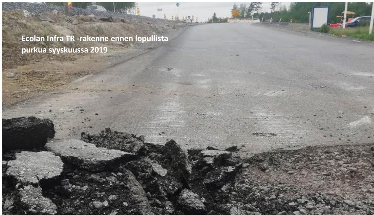
15 Kuva: Kiertotierakenteen purkaminen
