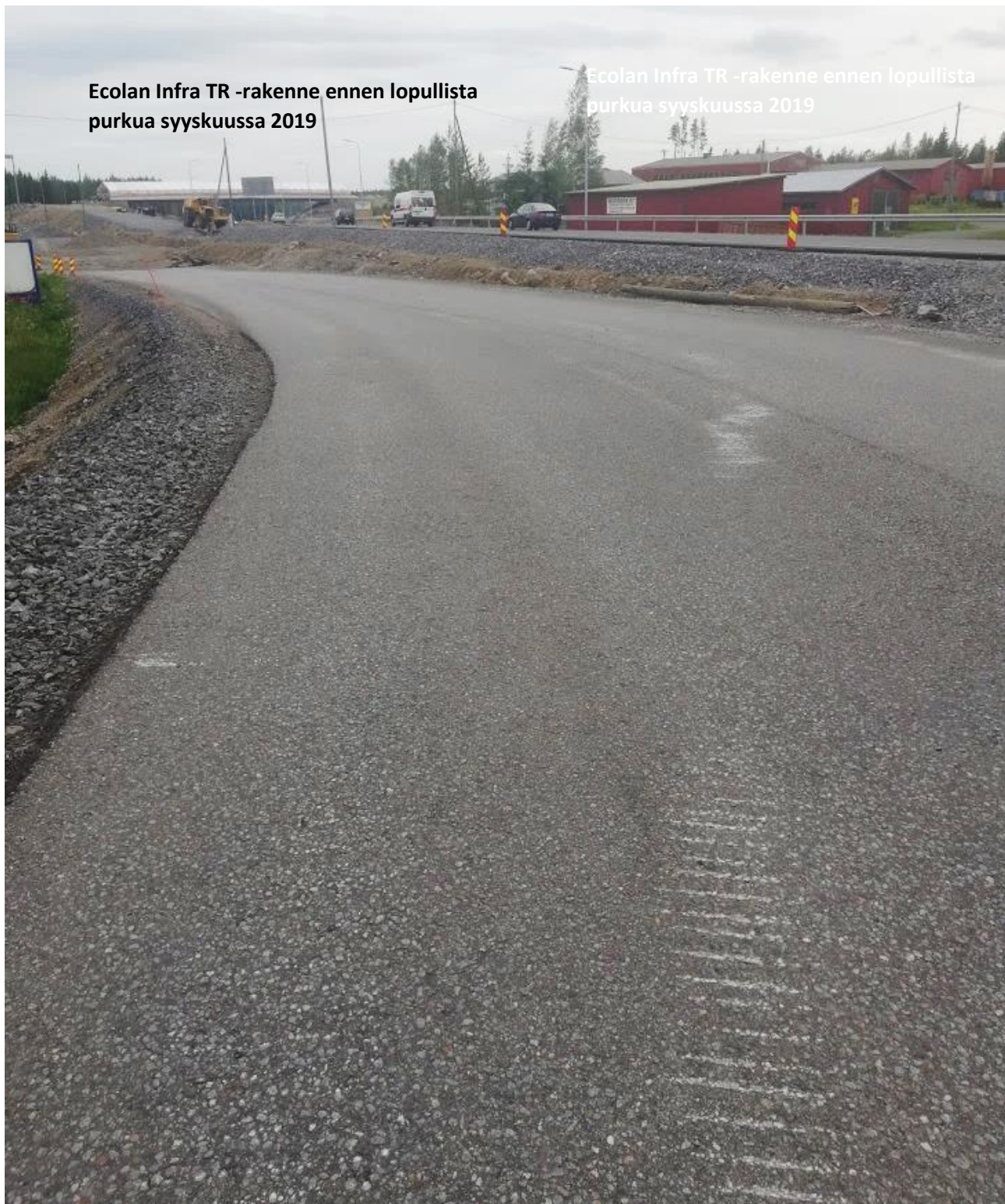
16 Kuva: Kiertotie odottamassa purkamista. Liikenne oli hieman aiemmin ohjattu uudelle väylälle.
