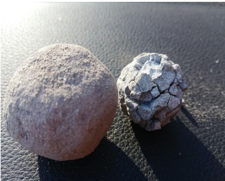
12 Kuva: Rakenteesta poistettuja tuhkarakeita
