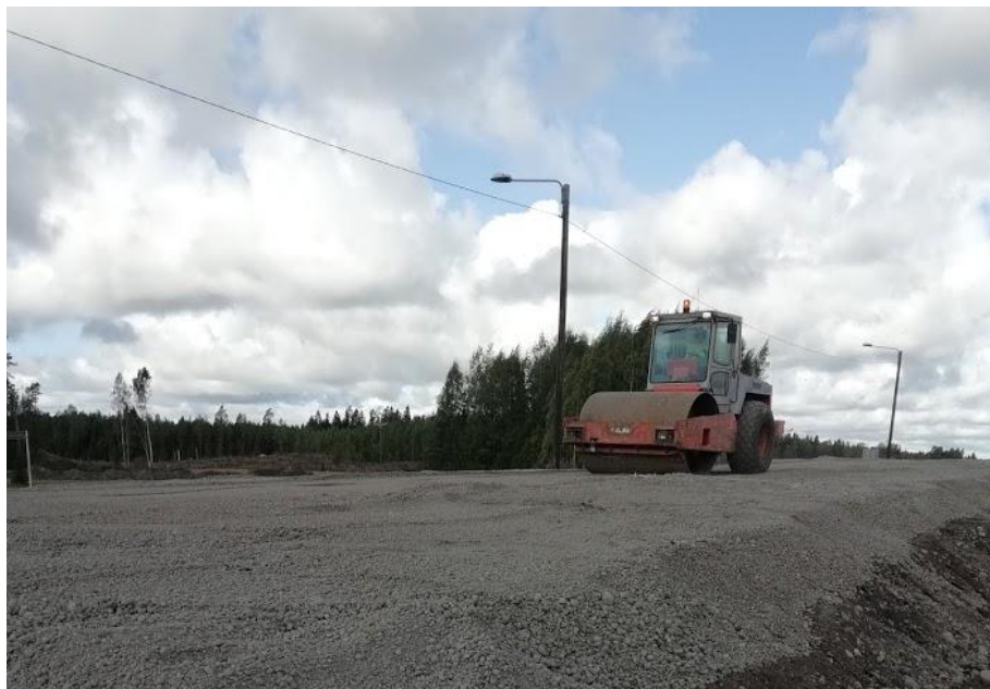
7. Kuva: Materiaali tiivistettiin 13 tn jyrällä.
