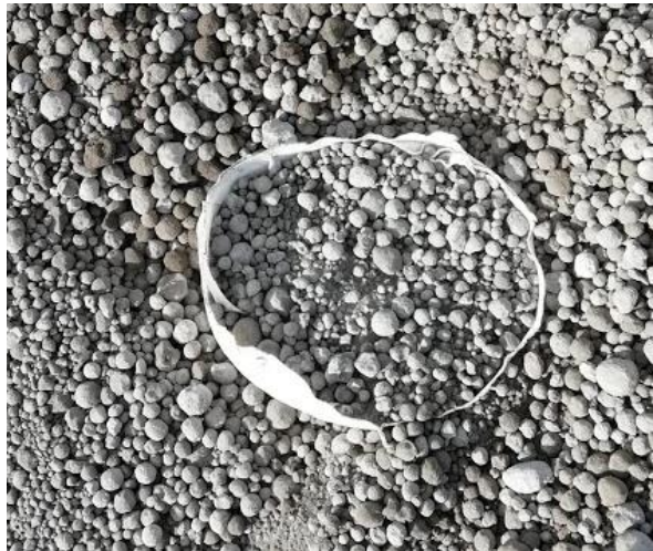
B Näyte rakenteessa odottamassa jyräystä.
