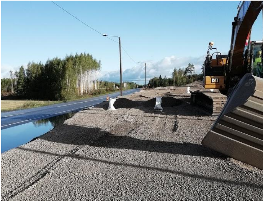
6 Kuva: Materiaalin levittämistä vaihtelevissa sääoloissa.
