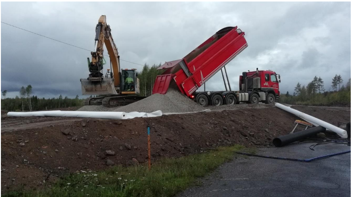
5 Kuva: Infra TR -materiaalin ajo rakenteeseen
