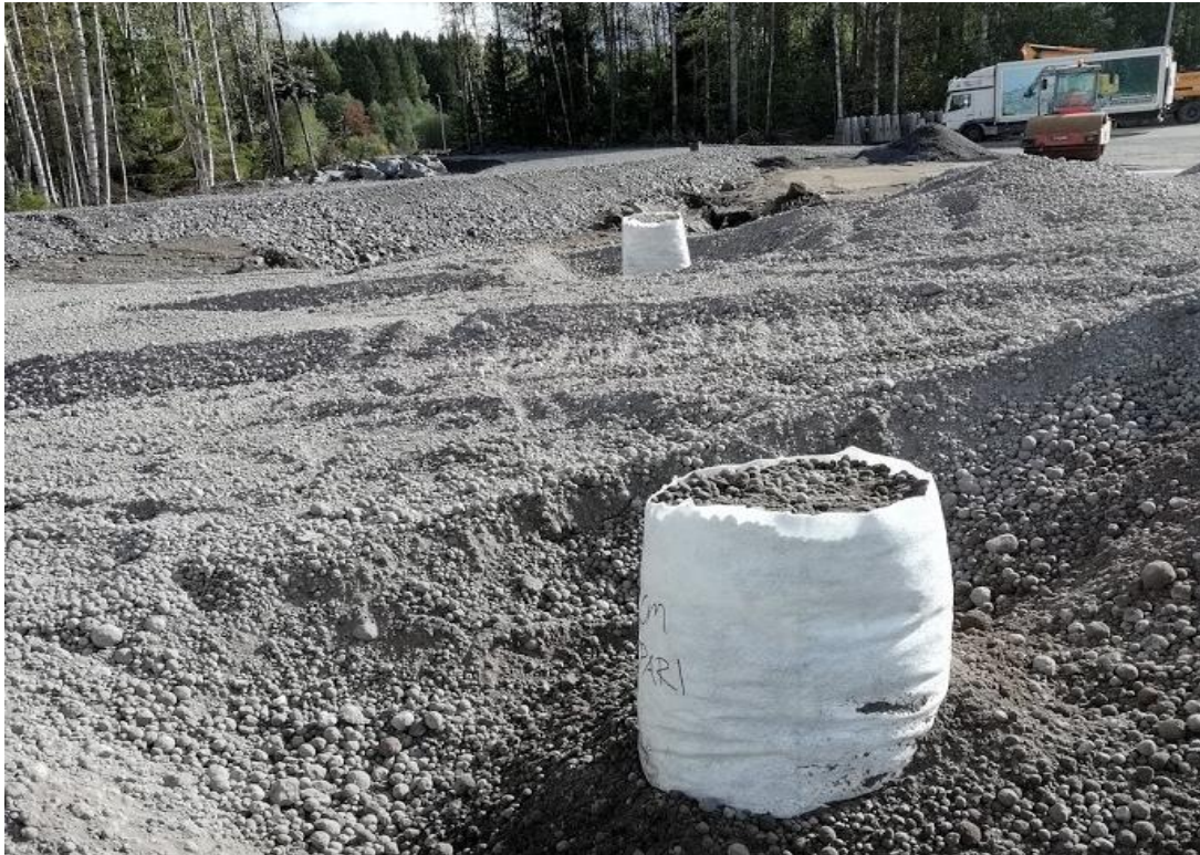
13 Kuva: Materiaalin yleisilmettä rakentamisvaiheessa syyskuussa 2018
