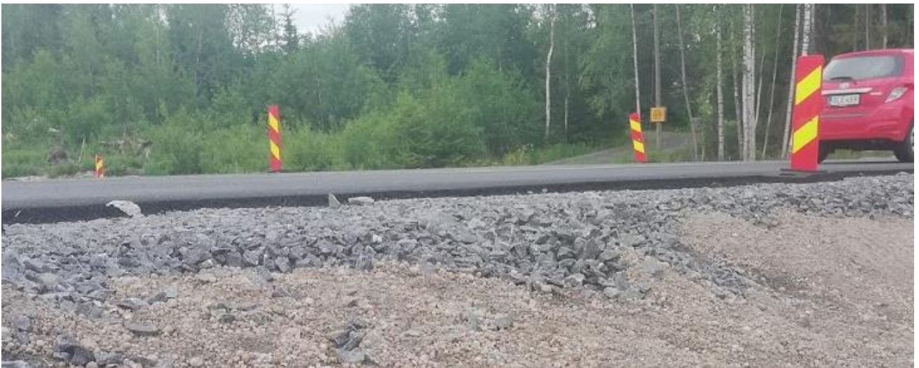
10 Kuva: AB-päällysteen paksuus kiertotiellä oli 70 mm, eli kyseessä oli ohutpäällysteinen väylä.
