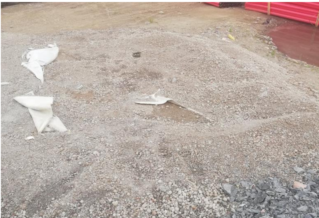
14 Kuva: Materiaalin yleisilme rakenteesta poistamisen jälkeen syyskuussa 2019
