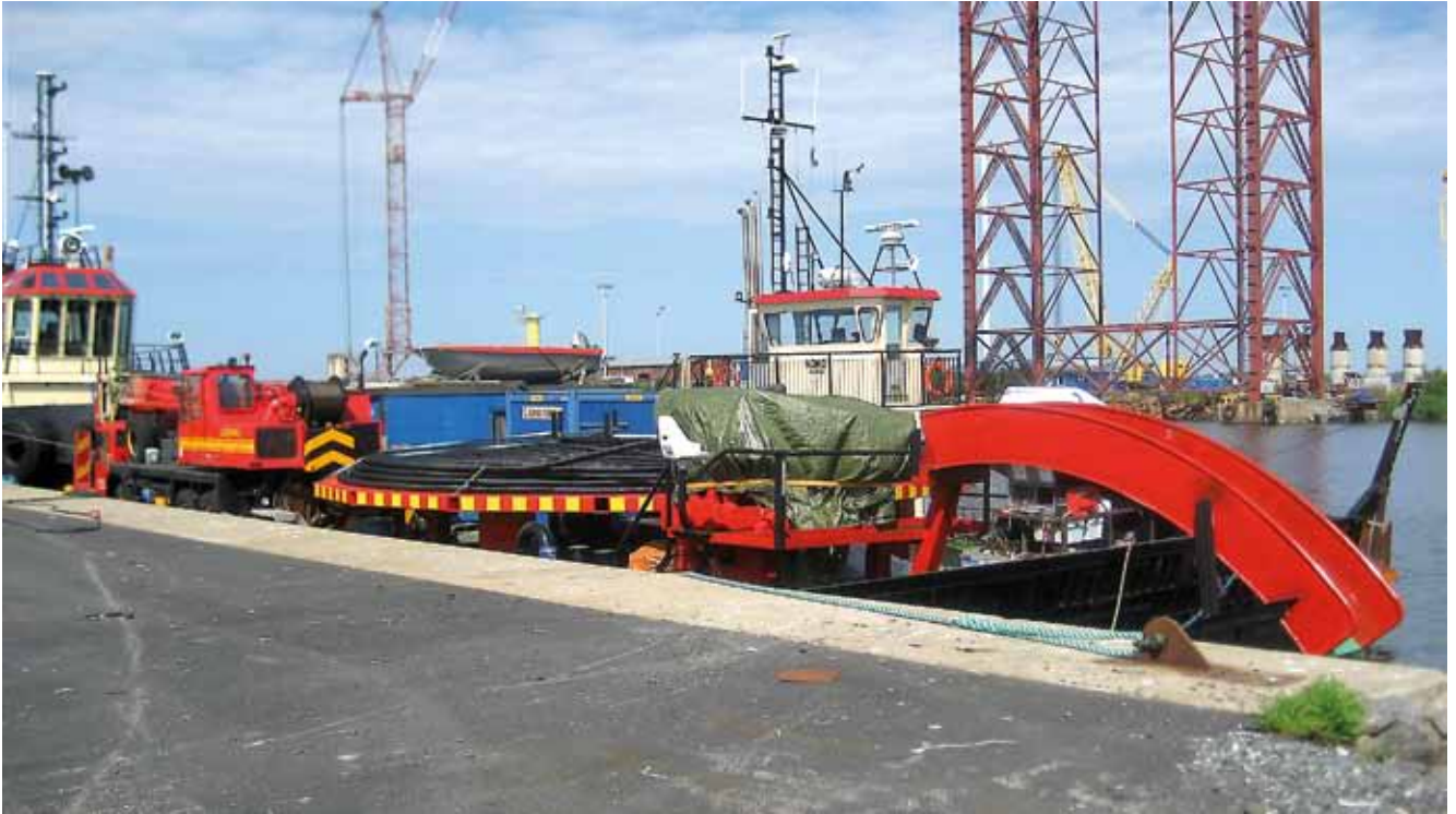
Kuva 13: Merikaapelin pohjaan asennukseen tarvitaan erikoisesti tätä tehtävää varten suunniteltuja aluksia. Kuvassa Finnish Sea Service Oy:n kalustoa. [5]
