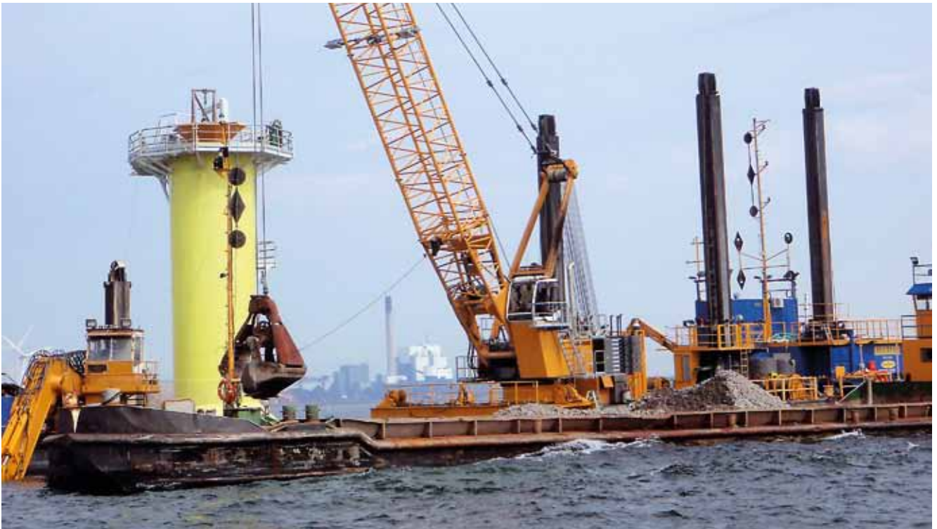
Kuva 15: Pori Offshore 1 -voimalan perustusta täytetään soralla [5]
