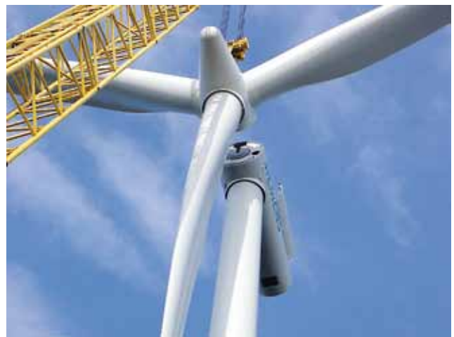
Kuva 12: Pori Offshore 1 - voimalan kokoonpanoa Meri-Porissa. Ensimmäiseksi asetetaan perustus. Tämän jälkeen kootaan torni ja viimeiseksi nostetaan roottori paikalleen [5].
