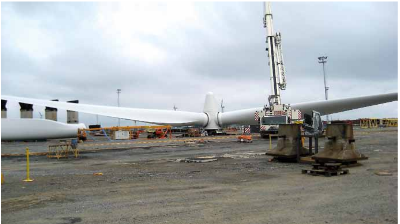
Kuva 11: Pori Offshore 1- voimalan turbiini odottamassa kokoonpanoa satamassa [5].
