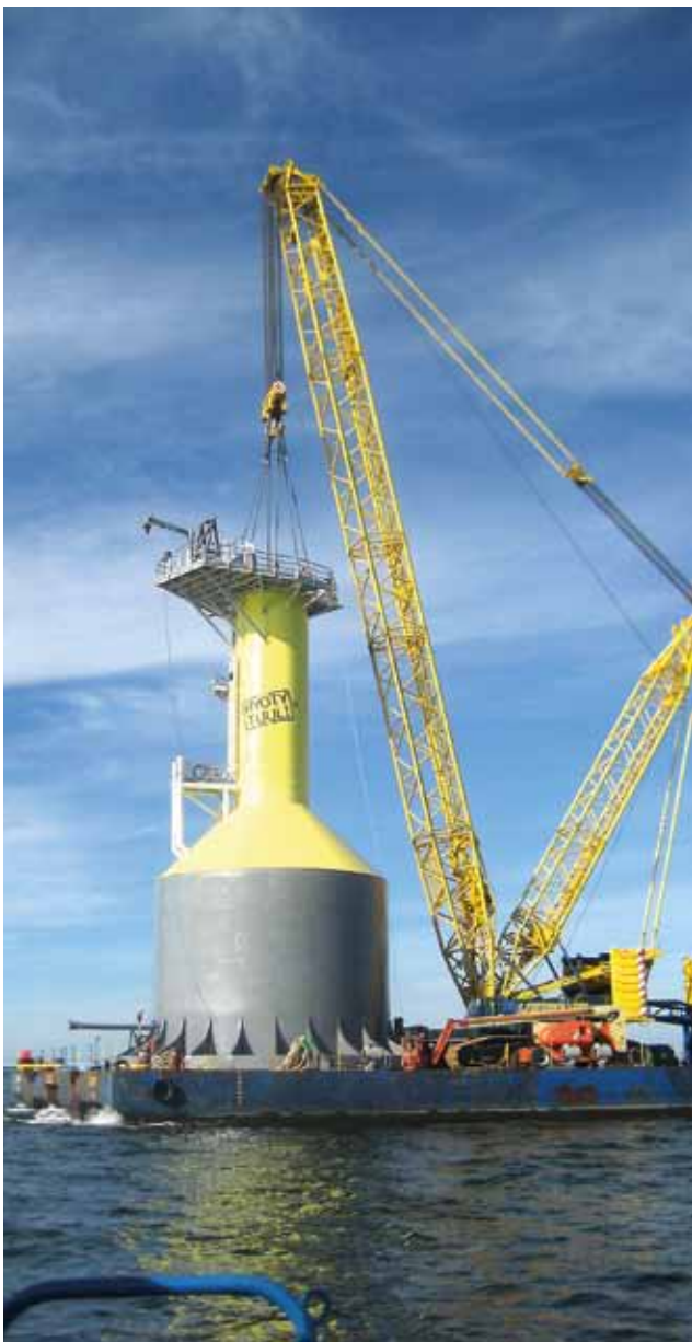
Kuva 12: Pori Offshore 1 - voimalan kokoonpanoa Meri-Porissa. Ensimmäiseksi asetetaan perustus. Tämän jälkeen kootaan torni ja viimeiseksi nostetaan roottori paikalleen [5].
