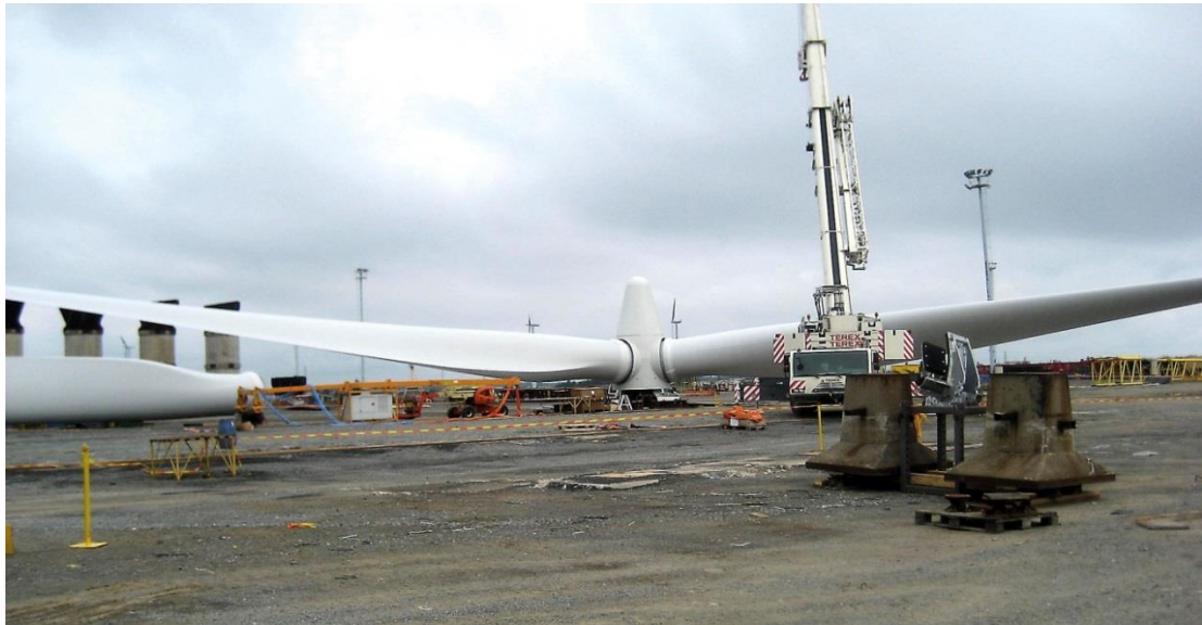
Kuva 2.4.7-1: Roottoria kootaan Technipin telakka-alueella Mäntyluodossa (Technip Offshore Finland Oy)
