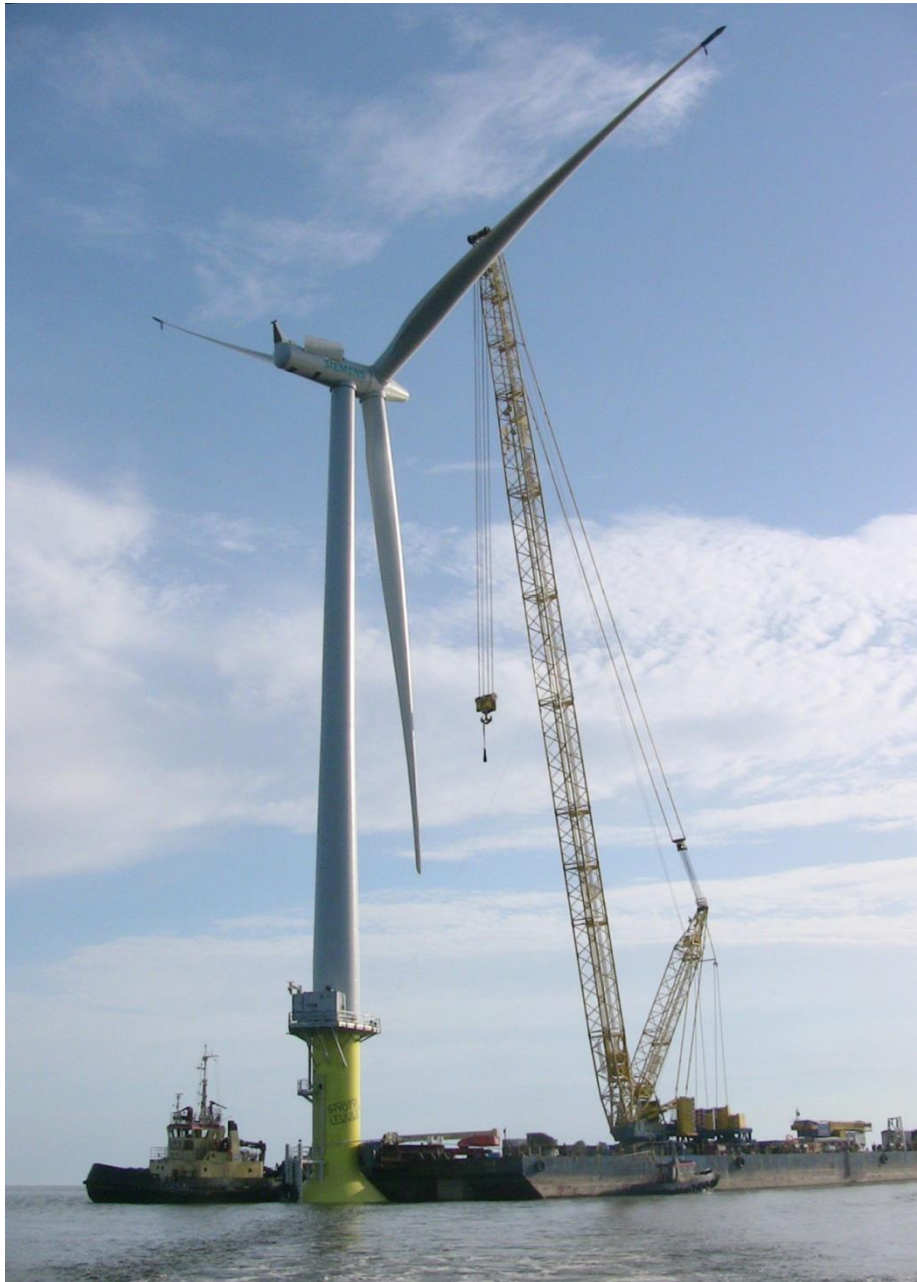
Kuva 2.5.3-1: Pori 1 turbiinin asennus (Technip Offshore Finland Oy)
