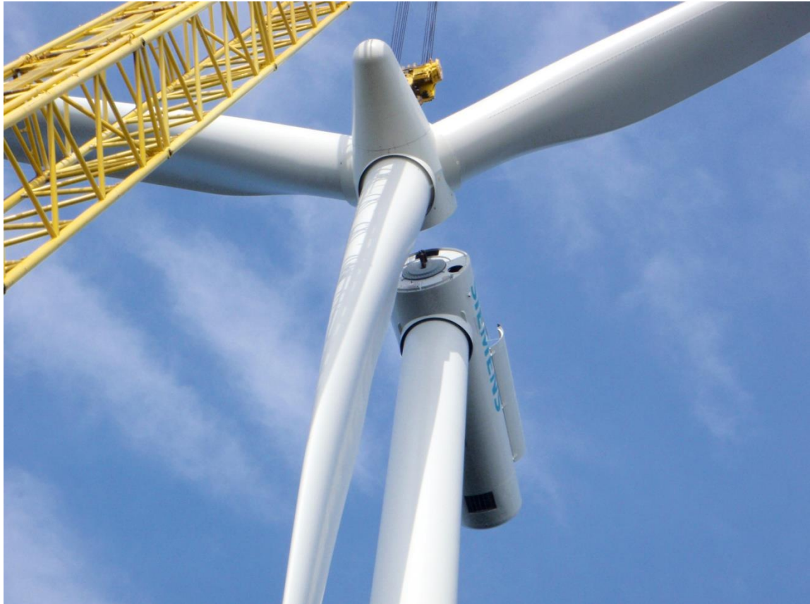
Kuva 2.5.3-2: Roottorin nosto paikoilleen naselliin. (Technip Offshore Finland Oy)
