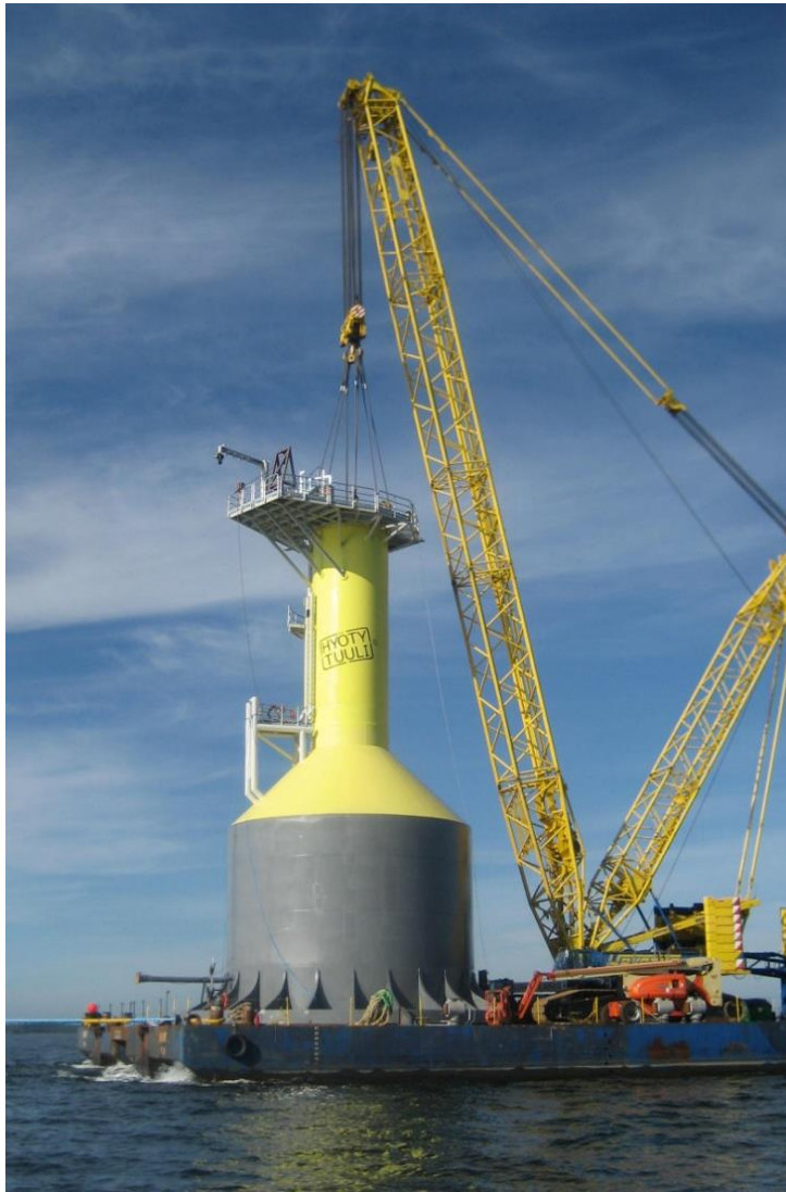
Kuva 2.5.2-1: Pori 1 perustuksen asennus (Technip Offshore Finland Oy)
