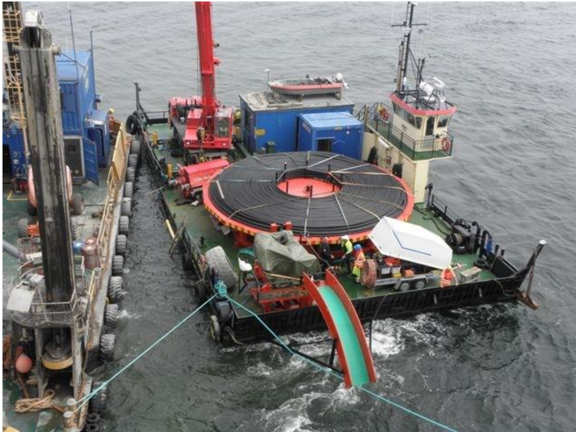
Kuva 2.5.4-1: Kaapelinelaskuproomu (Finnish Sea Service Oy)
