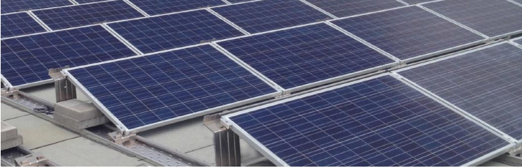
Kuva 8. Periaatekuva aurinkopaneelitelineestä, jotka soveltuvat huopatasakatonle asennettaviksi.
