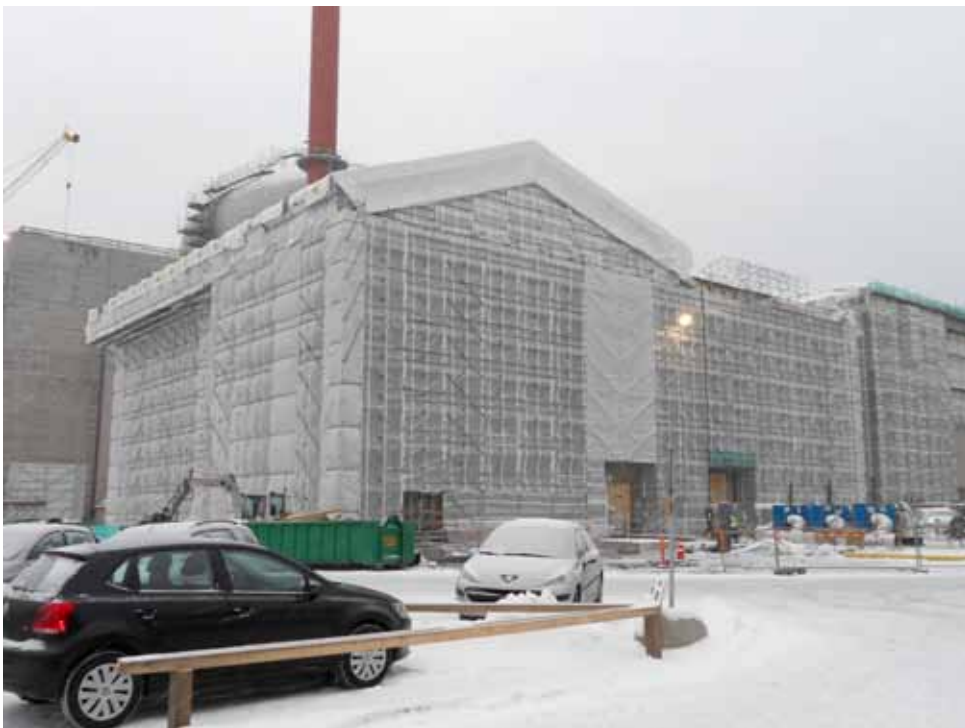
Kuva 13. Telineet ja sääsuojauskalusto ydinvoimalaitoksen rakennustyömaalla. Lähde: Ramirent Finland Oy
