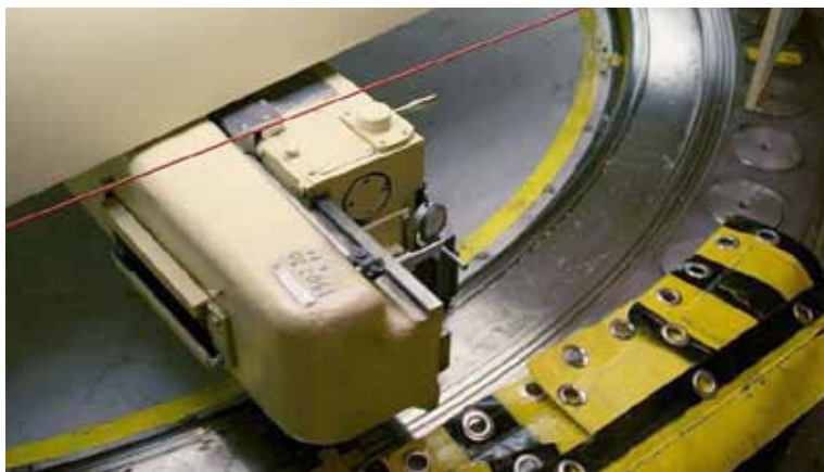
Kuva 14. Reaktoritankin kannen tiivistepinnan kunnostus. Lähde: IS Technics Oy
