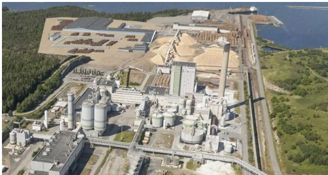
RAUMA SAWMILL PROJECT, METSÄ FIBRE OYJ RAUMA, 51 000 m 2 , plot 10 ha, Built 2020-2022 Metsä Fibre - Rauma sawmill (metsafibre.com)
