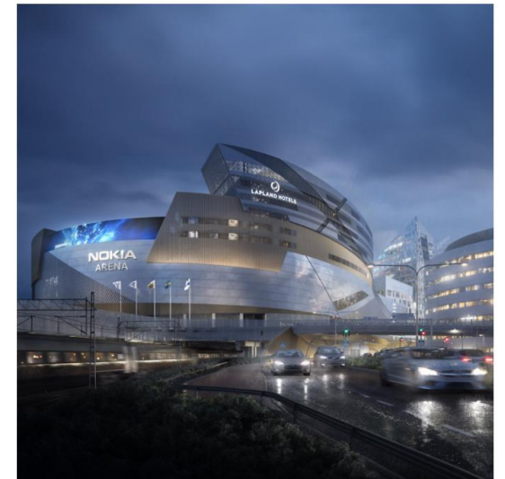
AREENA LÄMMÖNTALTEENOTTO LÄMPÖPUMPPU NOKIA AREENA, TAMPERE
