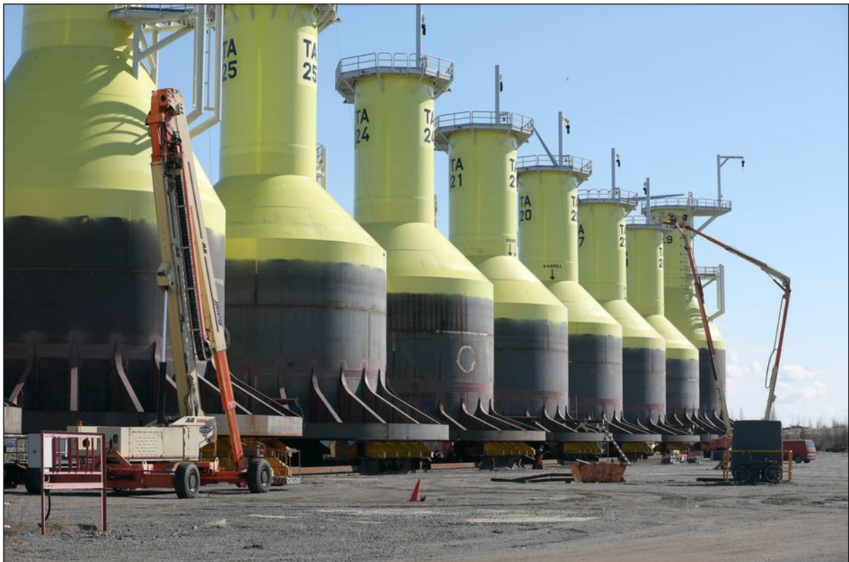
Kuva 12. Tahkoluodon merituulivoimaloiden perustuksia; paino 500 t/kpl (Kuva: Suomen Hyötytuuli Oy).
