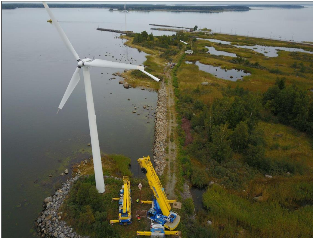
Kuva 19. Korsnäsin maatuulipuiston purkutyö ( https://www.delete.fi/2017/09/06/suomen-vanhin-tuulivoima-puisto-paatyy-purettuna-kierratykseen/ ).
