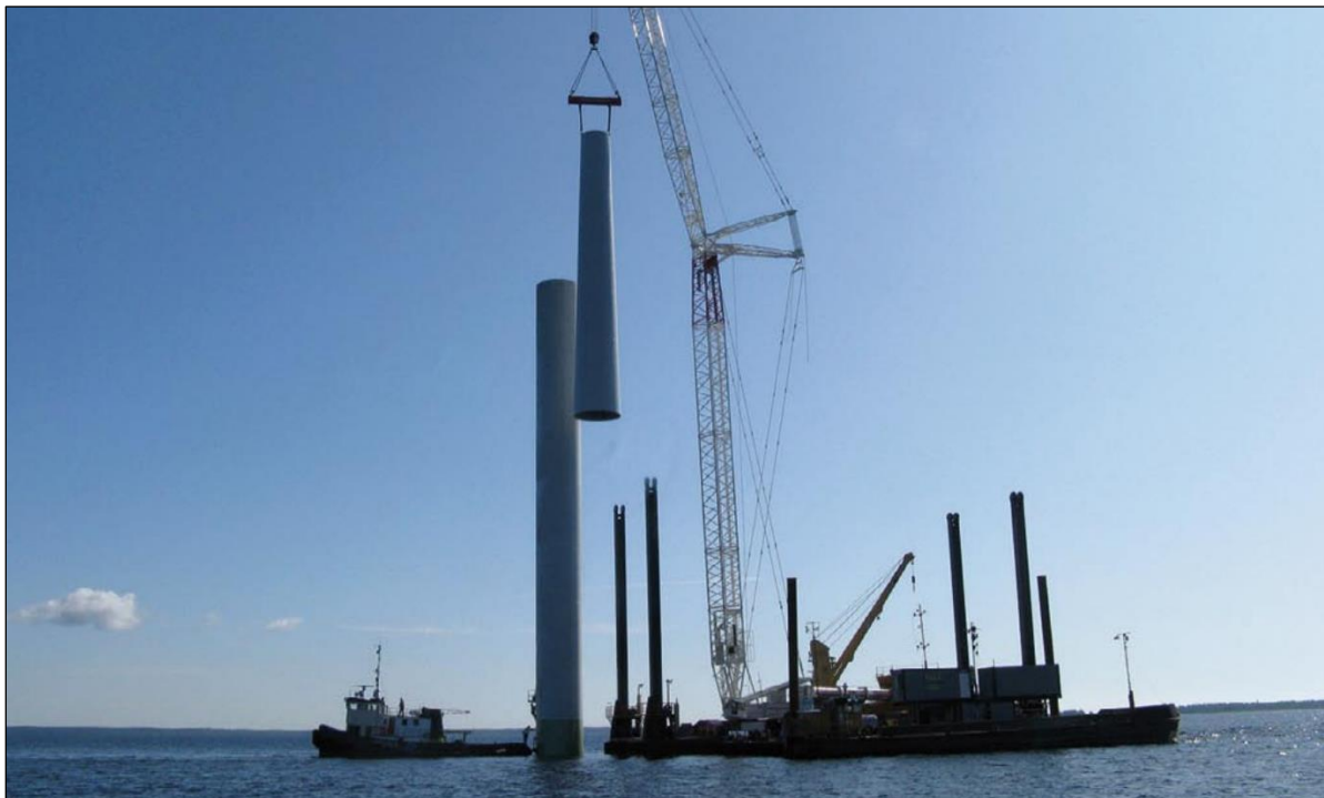
Kuva 15. Tuulivoimalaitoksen tornin pystytys käynnissä Ajoksen koeperustushankkeessa 2009 (Ajoksen merituulipuiston laajennus; YVA-selostus. Kuva: Kai Tirkkonen).
