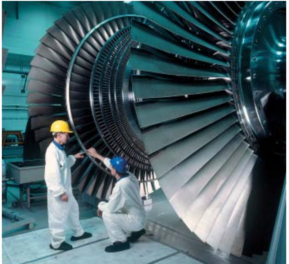
Vuosihuoltotöitä Olkiluodon turpiinihallissa. Kuva: TVO.
