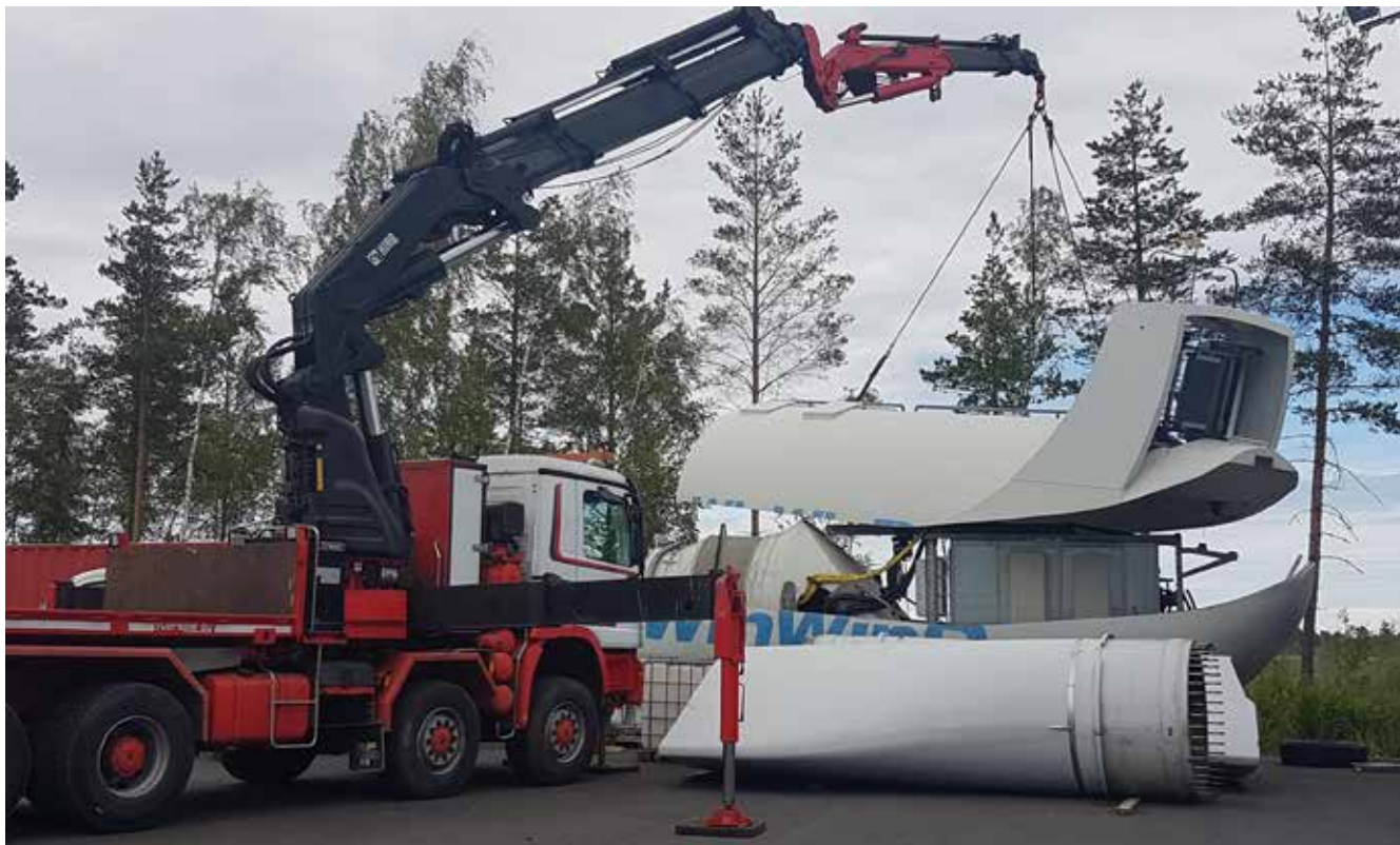
Nasellin katto oli ensin irrotettava ja nostettava sivuun, jotta päästiin käsiksi generaattoriin. Ennen katon nostoa täytyi huolehtia öljyjen ja jäähdytysnesteiden asianmukaisesta käsittelystä.
