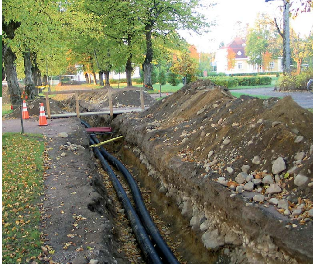
Lämmöntuotannolle sopivien alueiden huomioiminen kaavoituksessa on tärkeää. Lämmönjakoverkostojen rakentaminen taipuisalla putkella mahdollistaa verkon vapaamman linjauksen.
