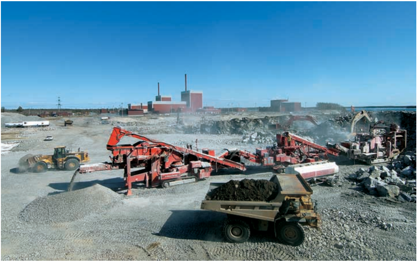
Kuva. TVO. Olkiluoto 3, louhintatyömaa.
