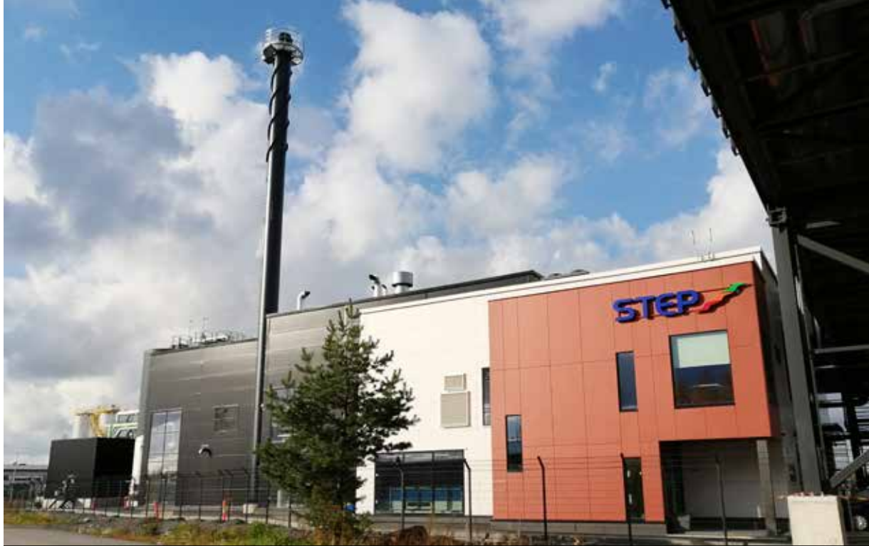
Suomen Teollisuuden Energiapalvelut - STEP Oy:n vuonna 2022 valmistunut tuotantohyödykelaitos Harjavallassa tuottaa BASF:n akkumateriaalitehtaalle mm. puhdasta vettä, höyryä ja paineilmaa.
