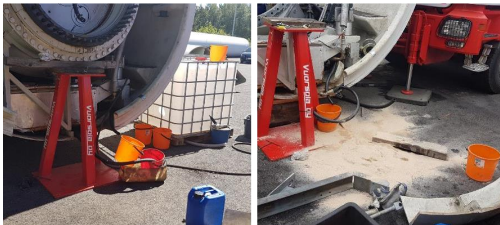
Kuva 2. Voimalaitoksen kuivaus letkuilla ja ämpäreillä.
