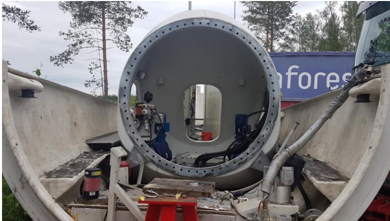
Kuva 9. Konehuone ilman voimalinjaa
