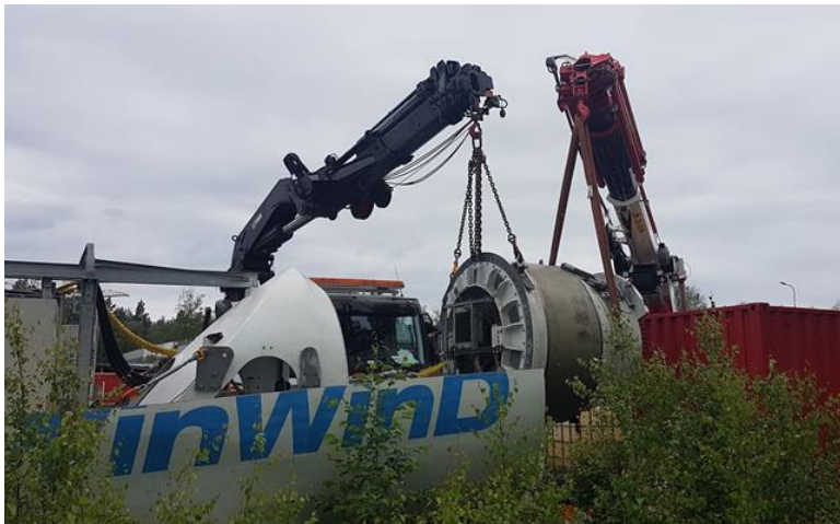
Kuva 7. Voimalinjan nosto kahden nosturin avulla
