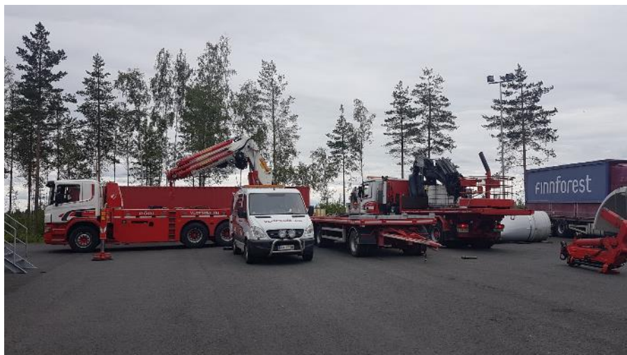
Kuva 5. Voimalinjan noston valmistelu
