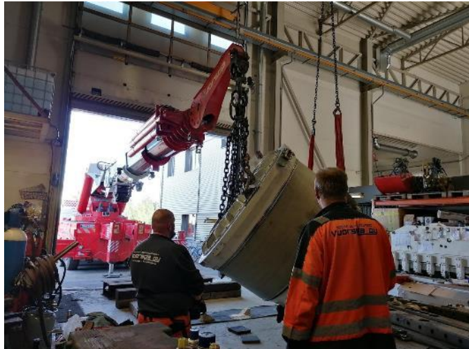
Kuva 11. Voimalinjan kääntäminen pystyyn
