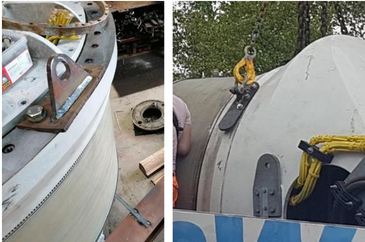
Kuva 6. Nostokorvakkeet, jotka valmistettiin ja kiinnitettiin voimalinjan nostoa varten
